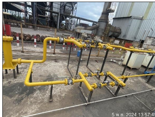
ภาพที่ 39 Safety Valve (LPG) เพื่อระบายความดัน
