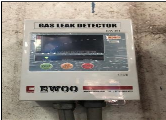
ภาพที่ 41 อุปกรณ์ตรวจวัดก๊าซรั่วไหล (Gas Detector)
