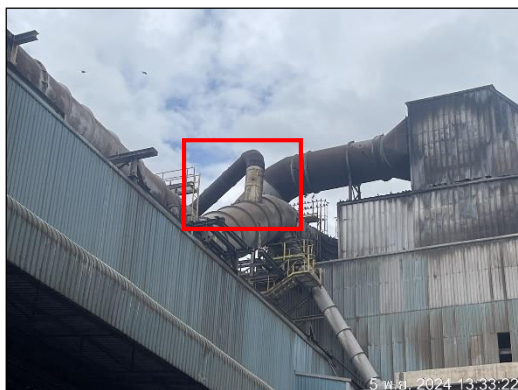
ภาพที่ 5 การติดตั้งระบบดูดฝุ่น Canopy Hood
