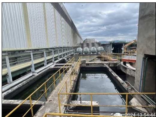
ภาพที่ 24 ระบบดักน้ำมันและกรองทราย
