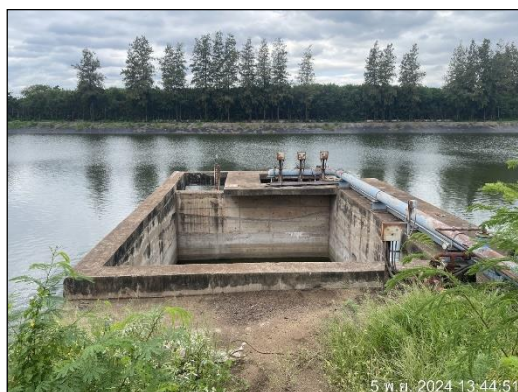
ภาพที่ 20 บ่อดักตะกอนชนิดบ่อกอนกรีต ขนาด 900 ลูกบาศก์เมตร
