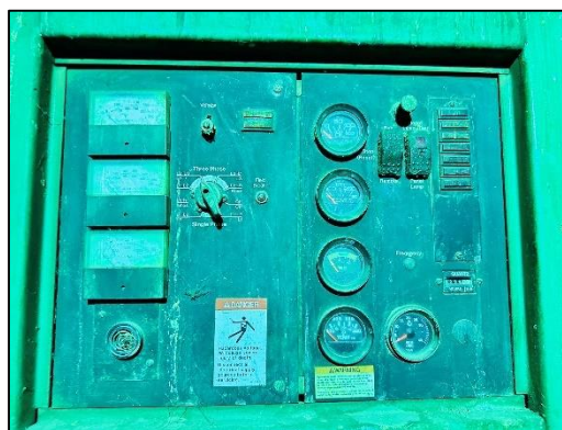
ภาพที่ 3 เครื่องสำรองไฟฟ้าสำหรับจ่ายไฟฟ้าให้ระบบบำบัดมลพิษทางอากาศ
