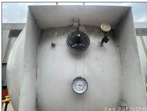
ภาพที่ 38 มาตรวัดแรงดันก๊าซ และอุปกรณ์ควบคุมความดัน
