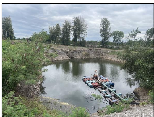
ภาพที่ 18 บ่อดักตะกอน ขนาด 3,000 ลูกบาศก์เมตร
