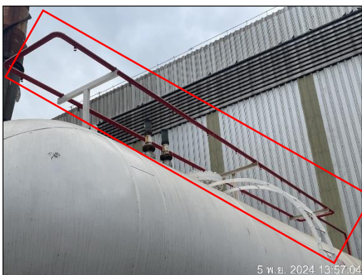
ภาพที่ 37 ระบบ Sprinkler เพื่อระบายความร้อน
