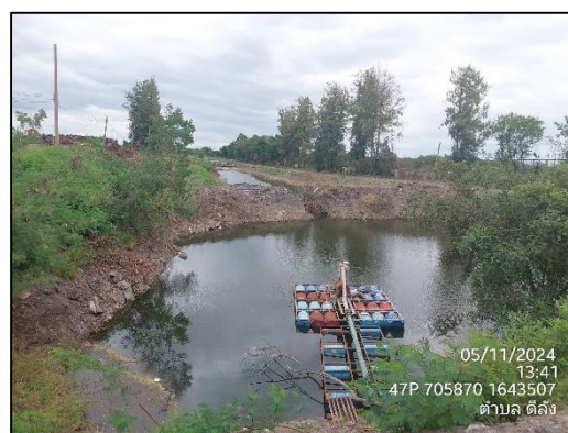
ภาพที่ 18 บ่อดักตะกอน ขนาด 3,000 ลูกบาศก์เมตร
