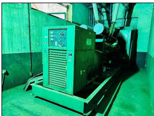
ภาพที่ 3 เครื่องสำรองไฟฟ้าสำหรับจ่ายไฟฟ้าให้ระบบบำบัดมลพิษทางอากาศ
