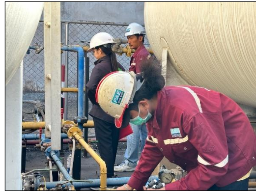
ภาพที่ 40 กิจกรรมตรวจสอบ Safety Valve (LPG)
