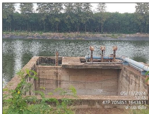
ภาพที่ 20 บ่อดักตะกอนชนิดบ่อกอนกรีต ขนาด 900 ลูกบาศก์เมตร
