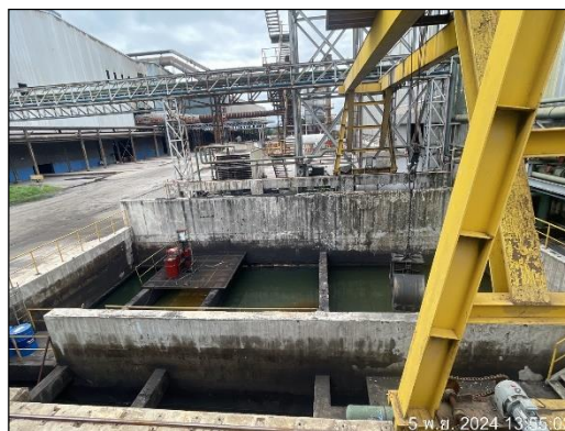
ภาพที่ 24 ระบบดักน้ำมันและกรองทราย
