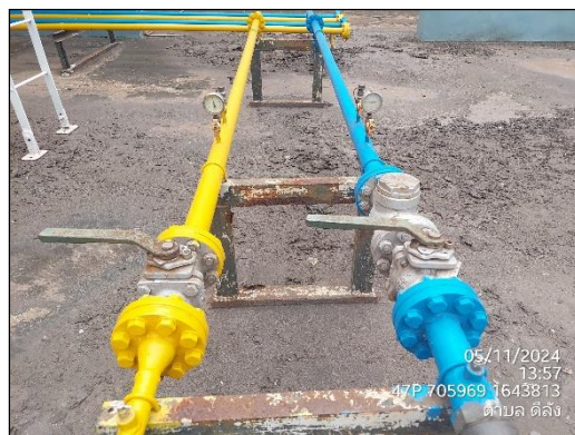
ภาพที่ 39 (ต่อ) Safety Valve (LPG) เพื่อระบายความดัน
