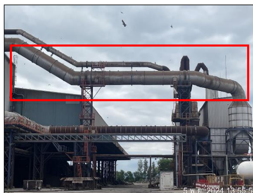
ภาพที่ 2 การติดตั้งระบบ Secondary Fume Exhausting
