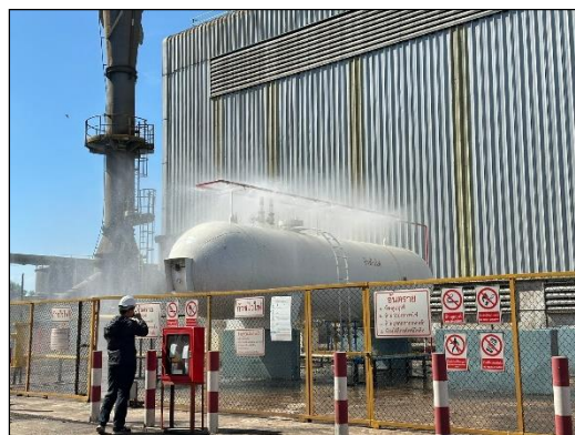
ภาพที่ 37 ระบบ Sprinkler เพื่อระบายความร้อน
